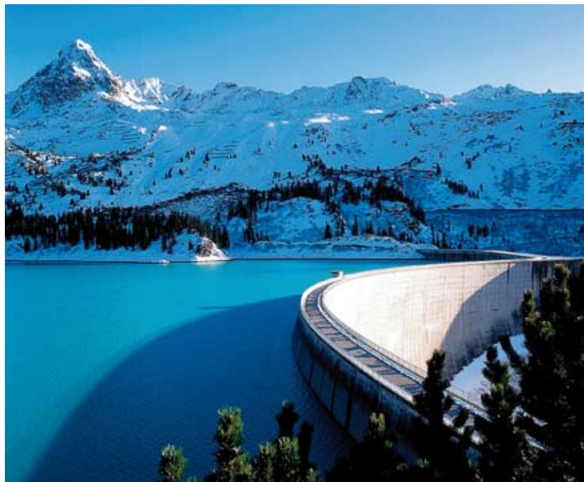
Kopsstausee, Österreich: am Projekt Kopswerk II ist Andritz VA TECH HYDRO mit wesentlichen Lieferungen beteiligt.
