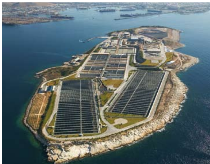
Kläranlage Psytalia, Athen, Griechenland: hier ist die größte Schlamm-trocknungsanlage Europas, geliefert von Andritz, installiert.
