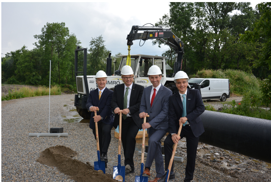
Spatenstichfeier im Juni 2016
