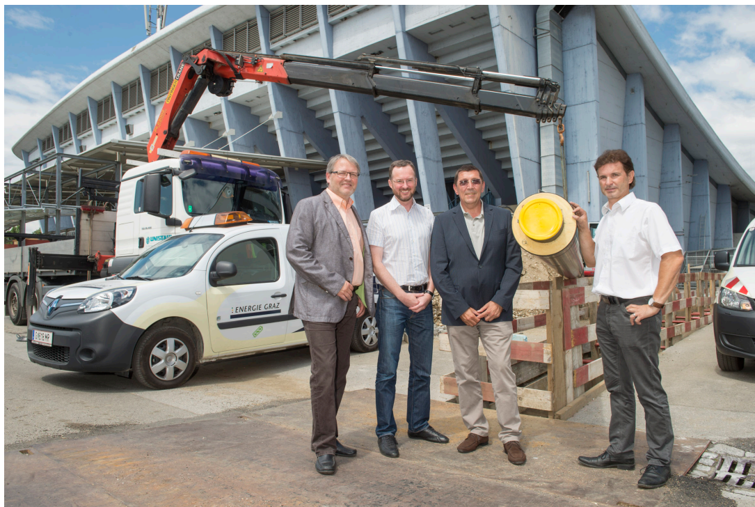
Leitungsbau Abwärmenutzung Eishalle Graz Liebenau
