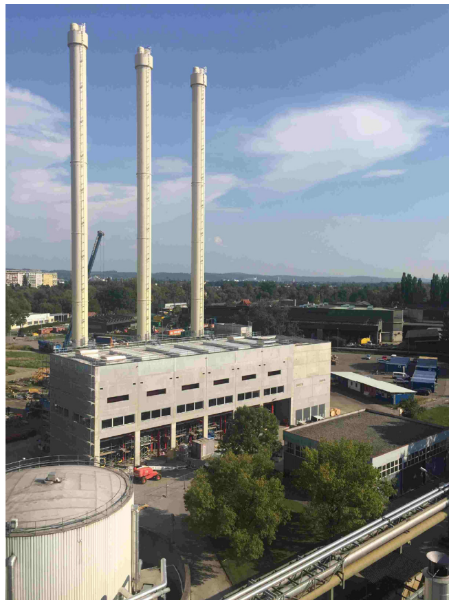
Erdgasbefeuerte Kesselanlage in der Fernwärme-Zentrale Graz
