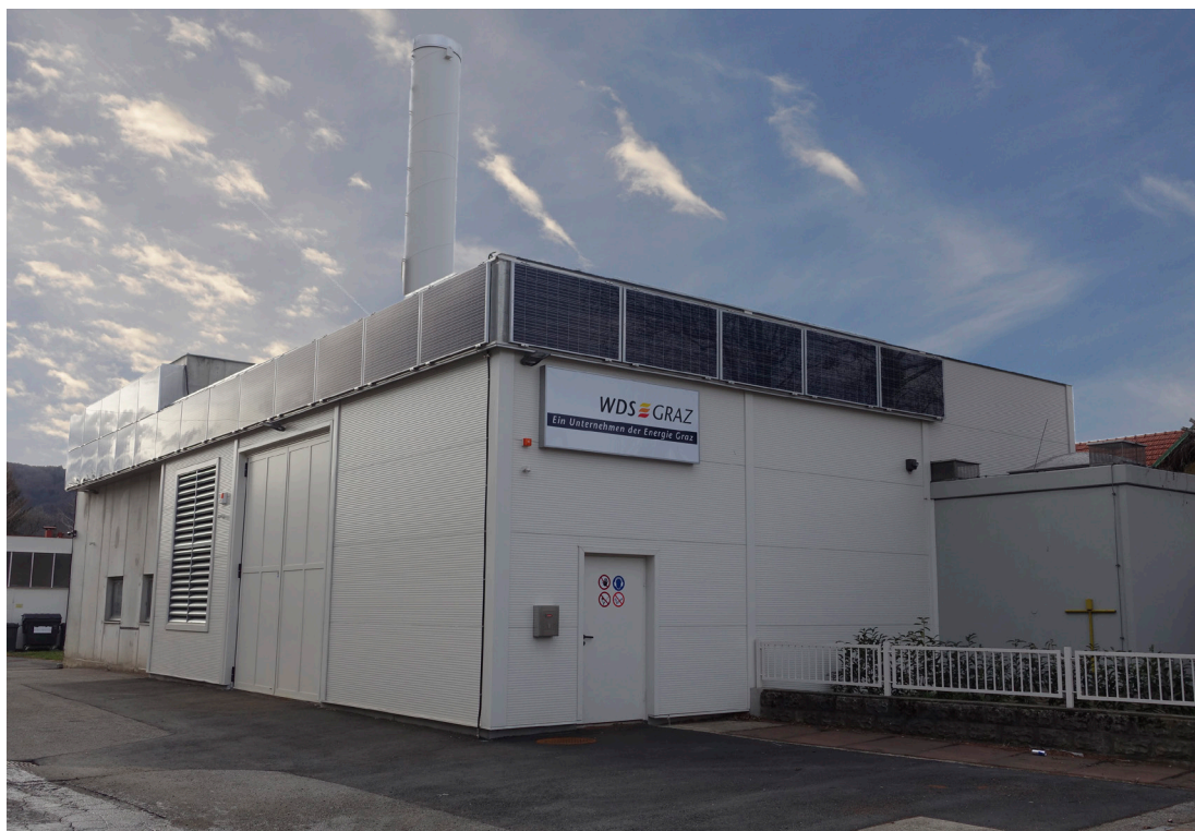
WDS Heizzentrale Waagner-Biro-Straße
